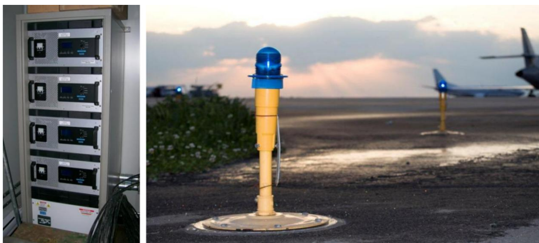
图 6-1 加拿大圣凯瑟琳斯机场低电流供电电源和滑行道边灯
