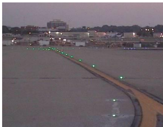
图 6-3 美国亚特兰大国际机场低电流供电的 LED 滑行道中线灯
