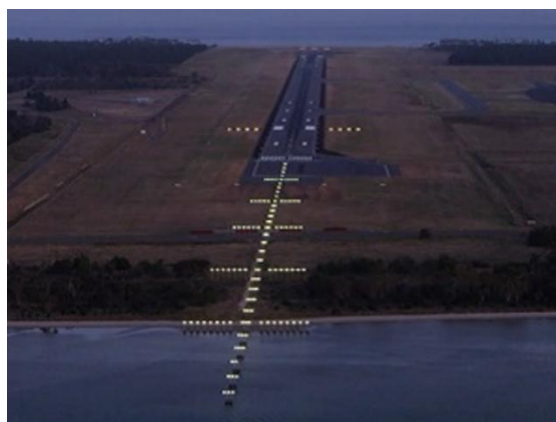
图 6-2 澳大利亚霍巴特国际机场低电流供电的进近灯光
