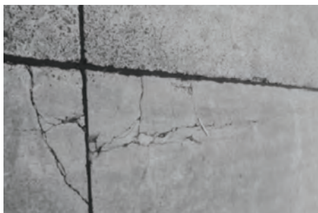
图 B.1.13-1 板角剥落（中等）
