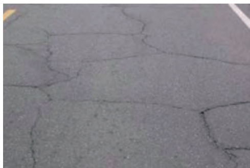
图 B.2.2-1 不规则裂缝（中等）
