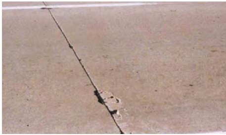
图 B. 1. 7-1 接缝破碎（轻微）
