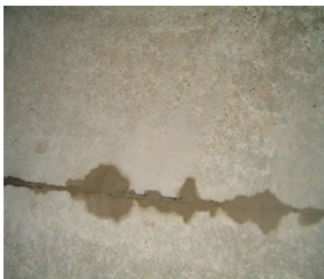
图 B. 1. 6-1 填缝料损坏（中等）
