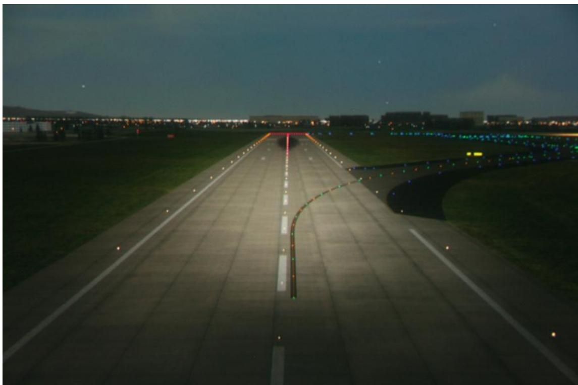
当从着陆跑道入口看时，跑道中线灯为白色，直至跑道最后 3000 英尺（900 米）。在接下来的 2000 英尺（600 米）白灯开始和红灯交替，在跑道最后 1000 英尺（300 米），所有跑道中线灯都为红色。
