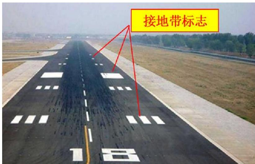
**说明:**接地带标志由若干对对称地设在跑道中线两侧的长方形标志块组成,接地带对数与可用着陆距离或跑道入口之间的距离的对应关系如下:
