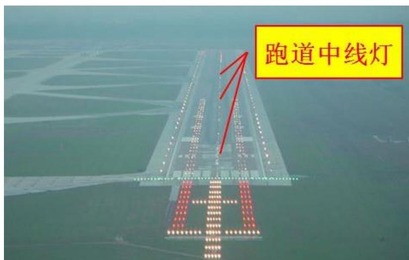
**说明：**跑道中线灯用于标明跑道中线位置，通常沿跑道中线设置，但实际安装时往往偏在跑道中线同一侧一小段距离。驾驶员在操纵飞机对准中线滑跑时，这段距离可忽略不计。
