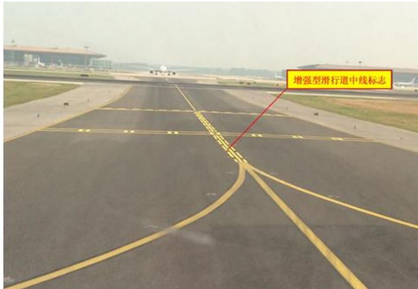
**说明：**增强型滑行道中线标志在普通滑行道中线两侧增加宽度0.15 m的黄色边线标志，并设置外边宽不小于0.05 m的黑色背景。增强型滑行道中线标志设置在与跑道直接相连的滑行道（单向运行的滑行道除外）上的A型跑道等待位置处，作用是为飞机驾驶员提供额外的确认A型跑道等待位置的目视参考，并构成跑道侵入防范措施的一部分。
