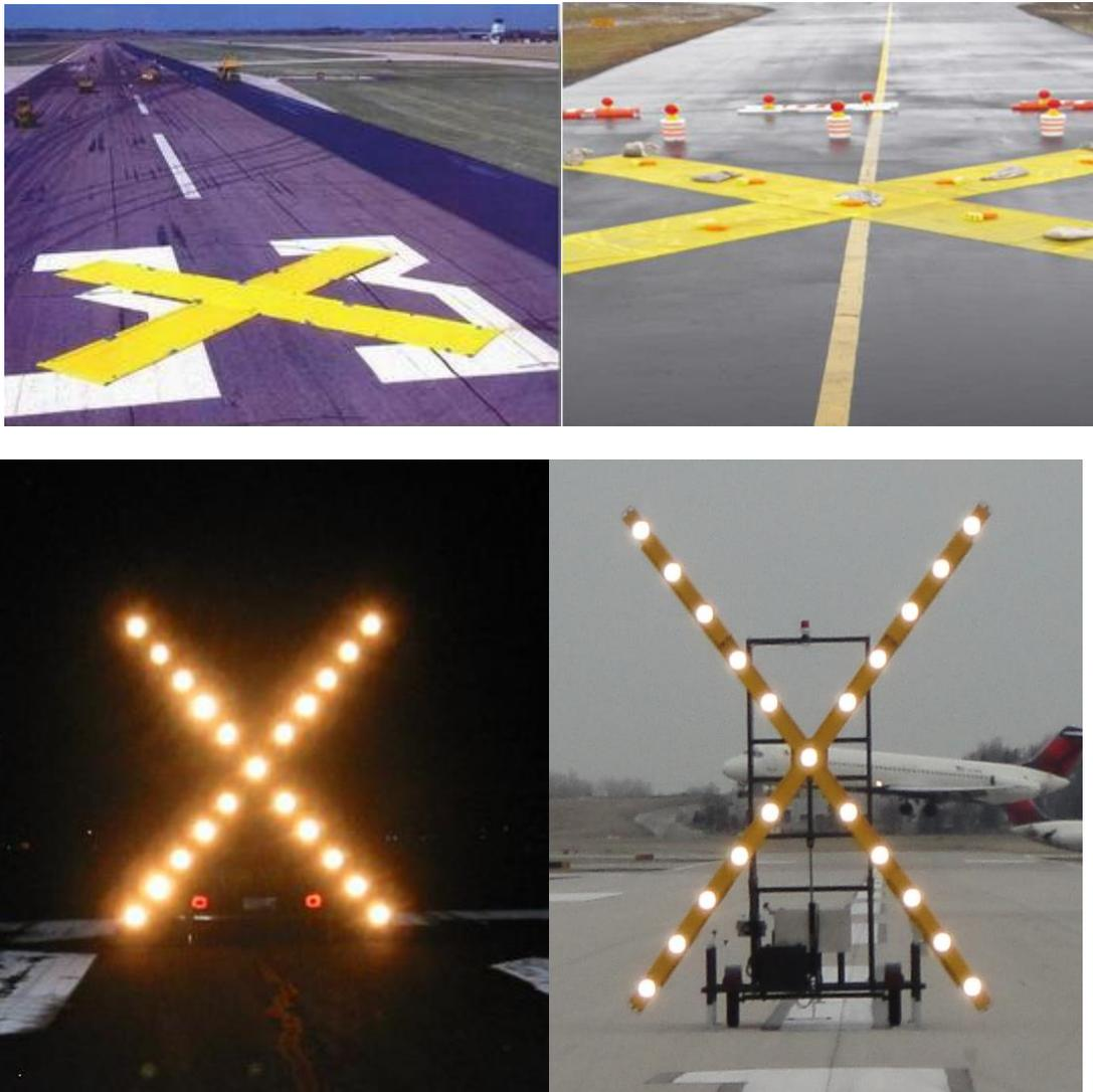
**说明：**关闭的跑道或滑行道标志表示相应的跑道或滑行道的全部或部分为关闭状态，禁止航空器使用。对所有航空器的使用永久关闭的跑道或滑行道或其部分，均设有关闭标志。
