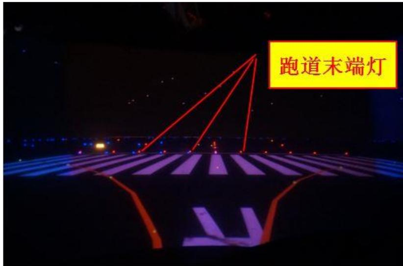
**说明：**跑道末端灯设置在有跑道边灯的跑道的末端，设计为向跑道方向发红色光的单向恒光灯，用于帮助驾驶员识别跑道末端。
