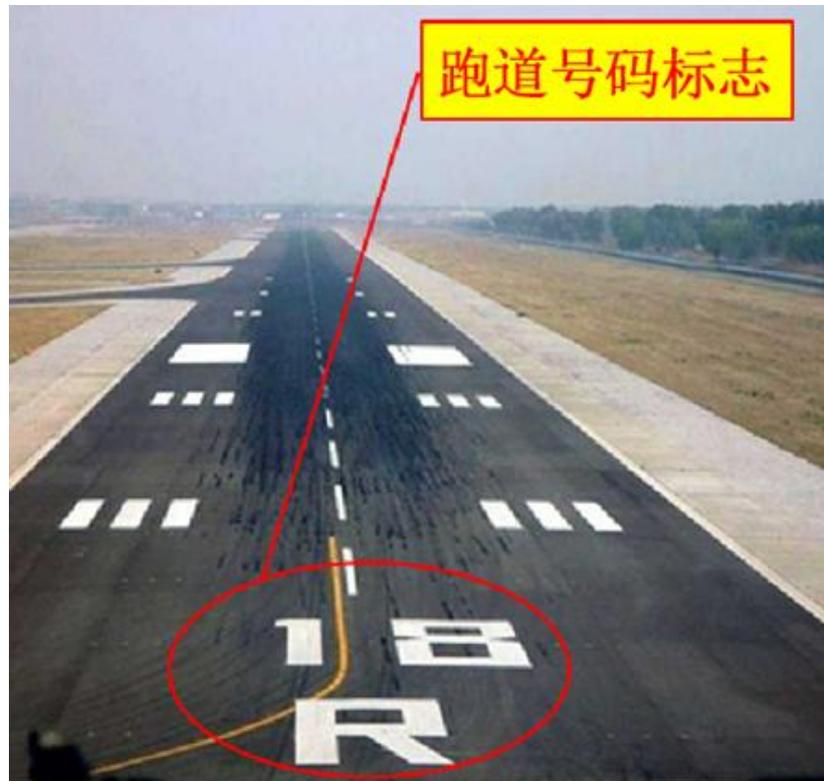
**说明：**跑道号码标志设置在跑道入口处，表明相关道面是跑道并显示具体的跑道号码。跑道号码标志由两位数字组成，这个两位数字是从进近方向看去最接近于跑道磁方位角度数的十分之一的整数。在有平行跑道的情况下，每个跑道号码标志后增加一个字母：
