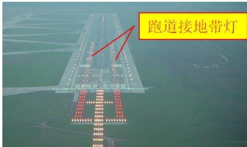
**说明：**接地带灯为单向发可变白光的恒光灯，由许多对对称于跑道中线的短排灯组成。接地带灯从跑道入口开始纵向延伸900m，标明跑道的大致接地区域。
