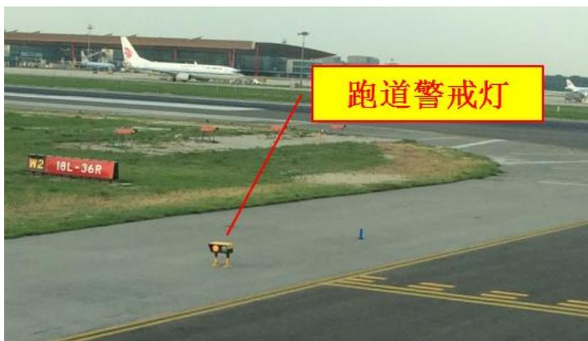
**说明：**跑道警戒灯的光束是单向的并对准方向使滑向等待位置的飞机驾驶员能看得见，用于警告在滑行道上操纵飞机的驾驶员和驾驶车辆的司机，他们将要进入一条现用跑道。
