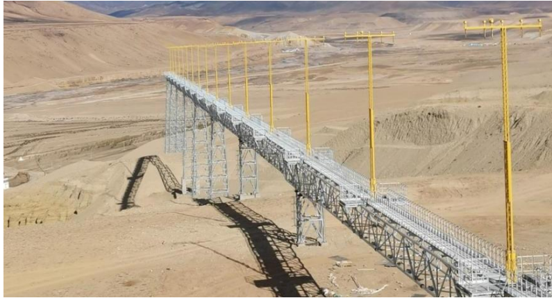
图 14.3-3 不易维护的进近灯光桥梁方案示意图
