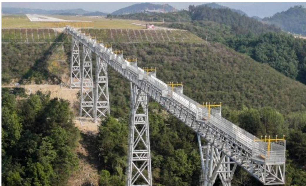
图 14.3-1 易于维护的进近灯光桥梁方案示意图 1
