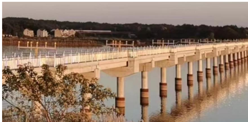
图 14.4-2 桥跨过小导致下部结构过多的方案
