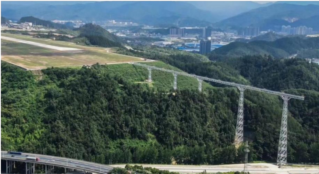
图 14.1 进近灯光桥梁建设案例
