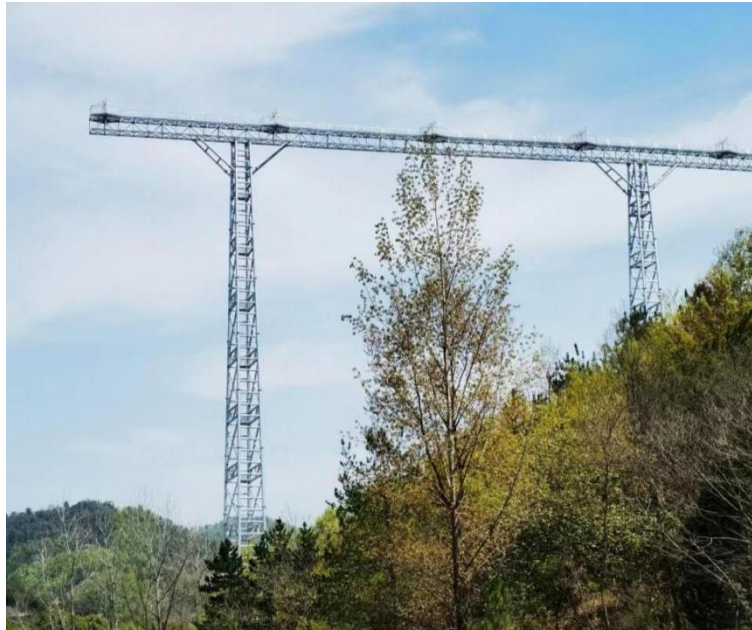
图 14.5 灯光桥边跨悬臂的长度需考虑其稳定性和疲劳效应
