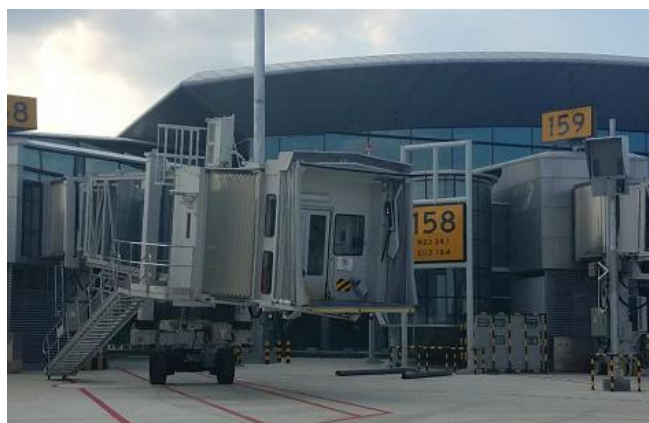
图 11.2-2 某机场 158 号机位标记牌被遮挡示意图
