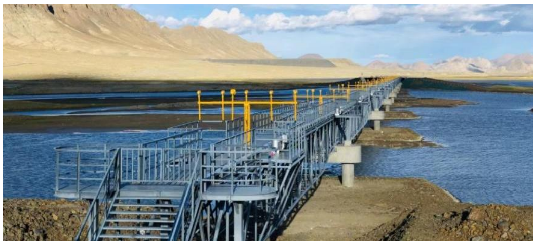
图 14.3-2 易于维护的进近灯光桥梁方案示意图 2
