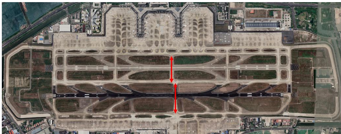
图 7.1-1 A 机场穿越道位于跑道中部的“高能量区”
