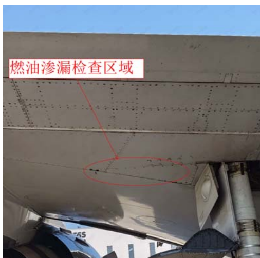
图 1 航线燃油渗漏检查示意图
