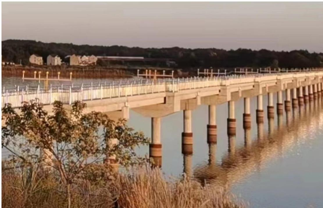
图 14.4-2 桥跨过小导致下部结构过多的方案
