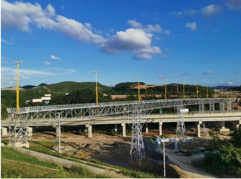
图 14.3-4 不宜维护的进近灯光桥梁方案示意 2
