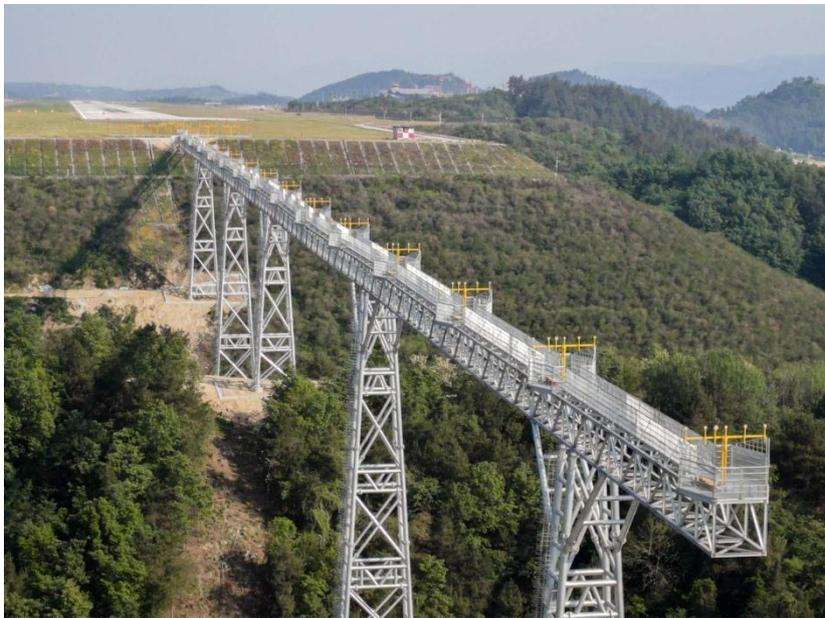
图 14.3-1 易于维护的进近灯光桥梁方案示意 1
