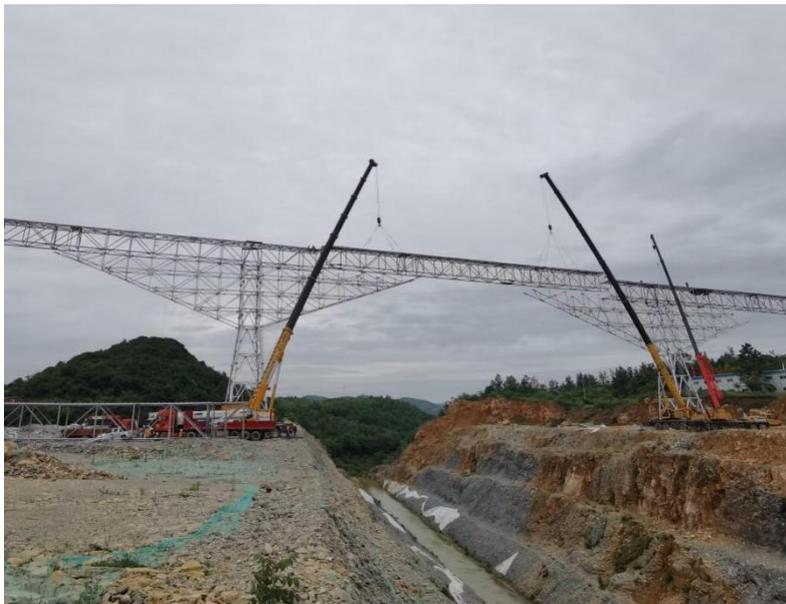
图 14.4-1 墩顶桁架用钢量过大导致重心偏高的方案
