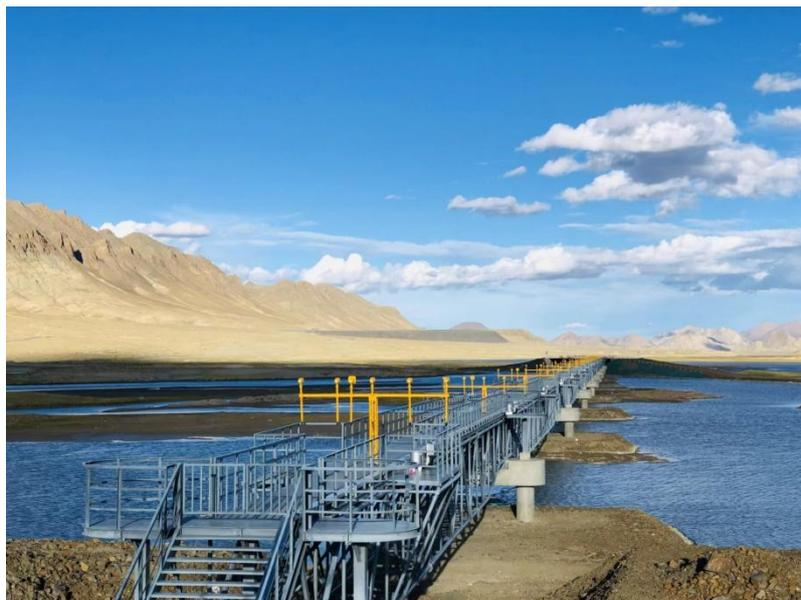
图 14.3-2 易于维护的进近灯光桥梁方案示意 2
