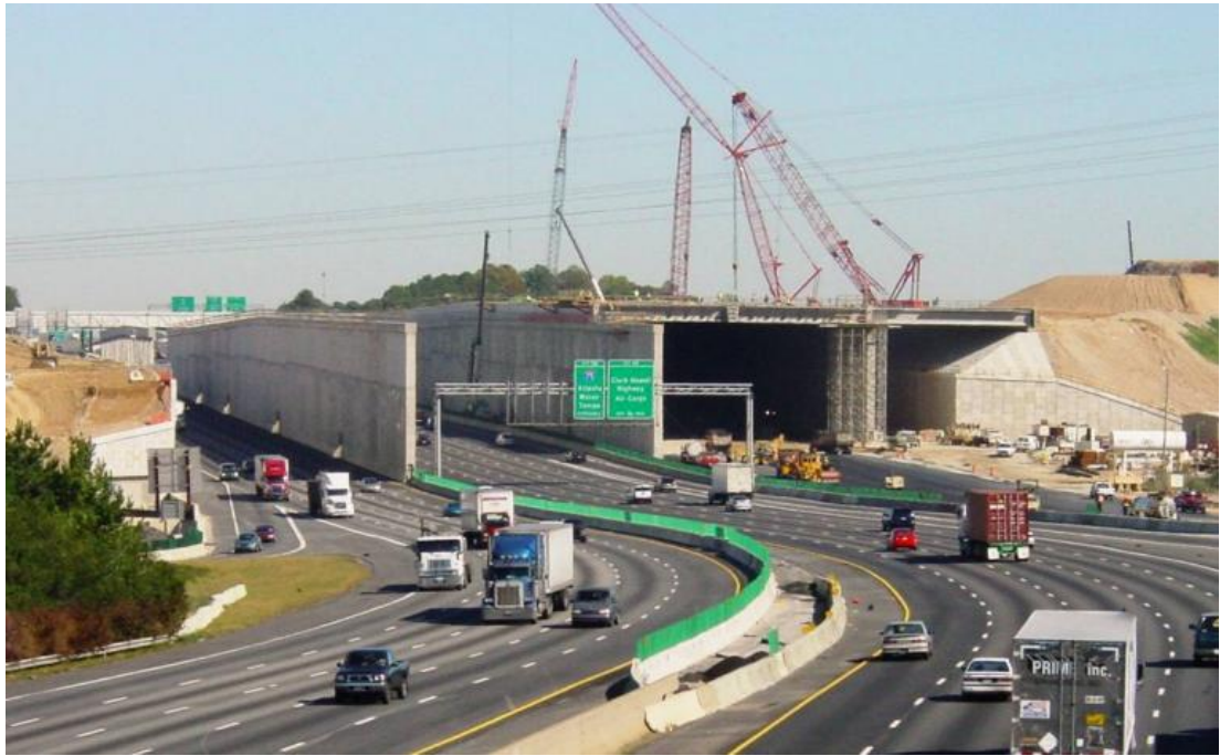
图 4- 4 亚特兰大机场第五跑道跑道桥施工
