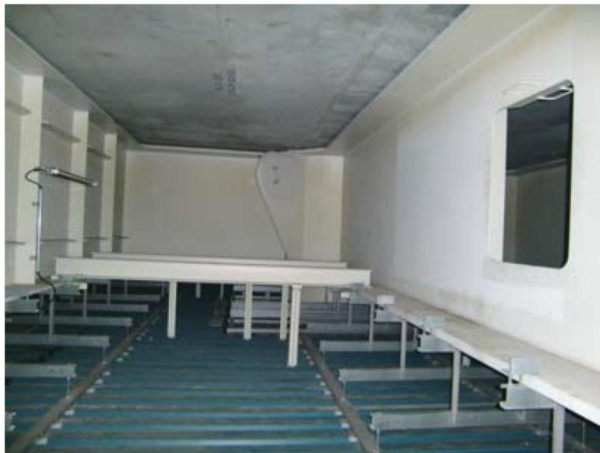
图 3- 7 钛钢涂层盖板内部形成的箱室
