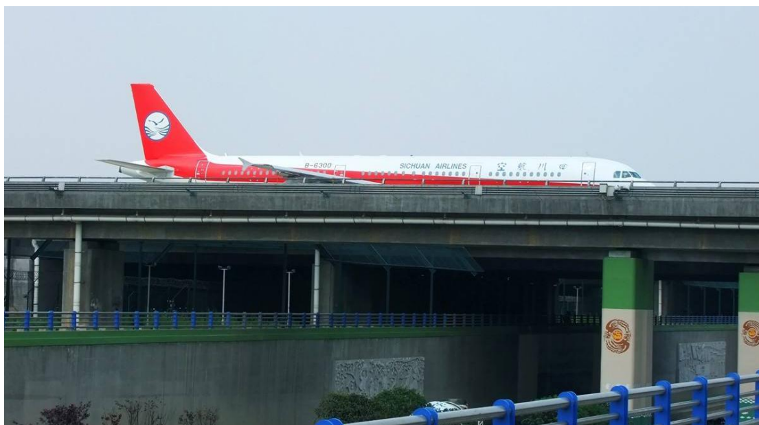
图 6- 12 成都双流机场大件路滑行道桥
