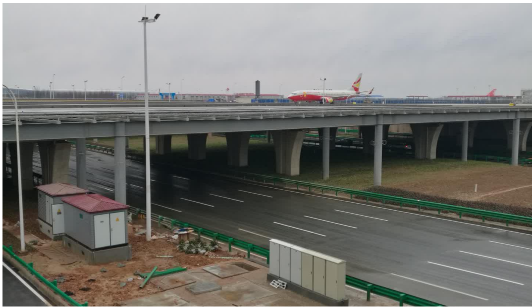
图 6- 14 武汉天河国际机场滑行道桥
