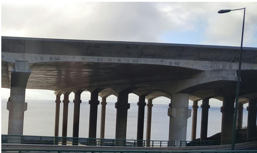
图 2-7 跑道桥侧面照片
