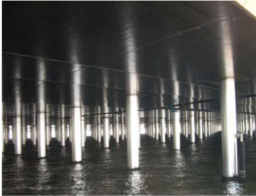
图 3- 6 桥梁钢套筒结构防腐
