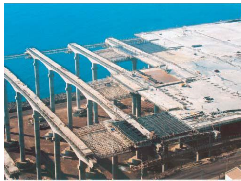
图 2- 15 桥面板施工
