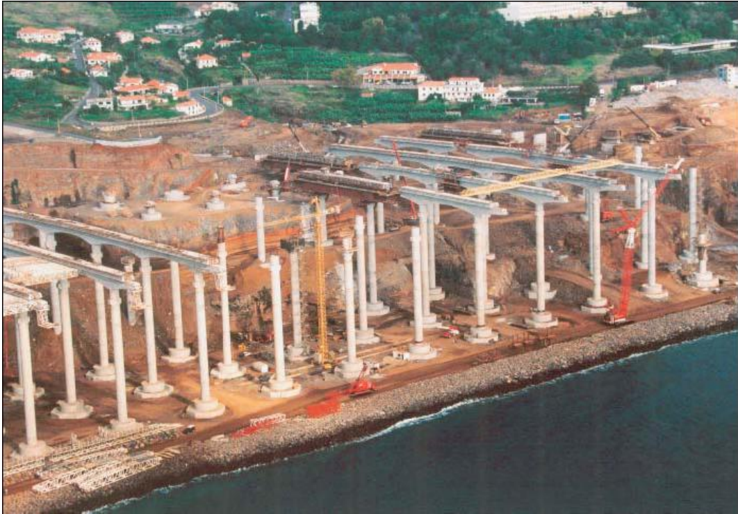
图 2- 12 填海围垦地上的桥墩（施工中）
