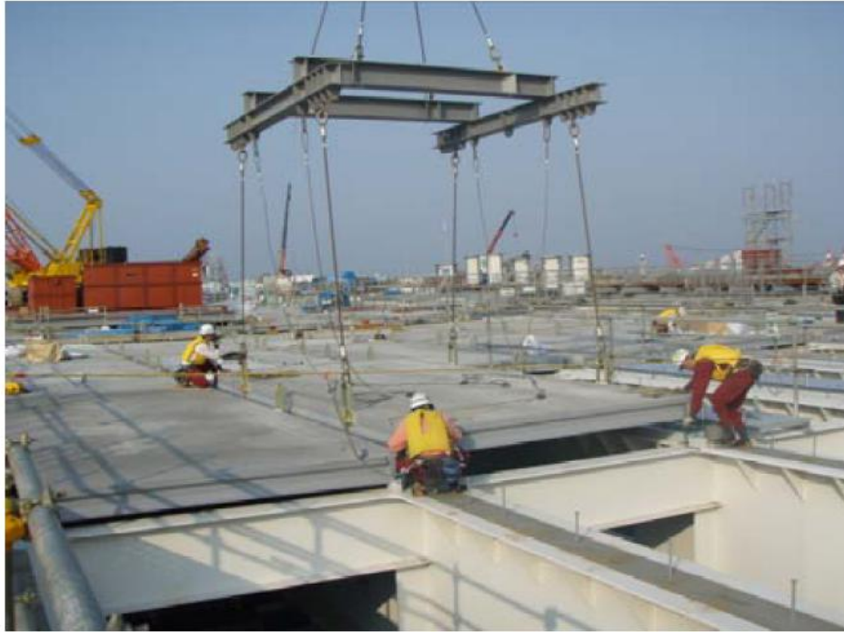
图 3- 13 UFC 板安装现场
