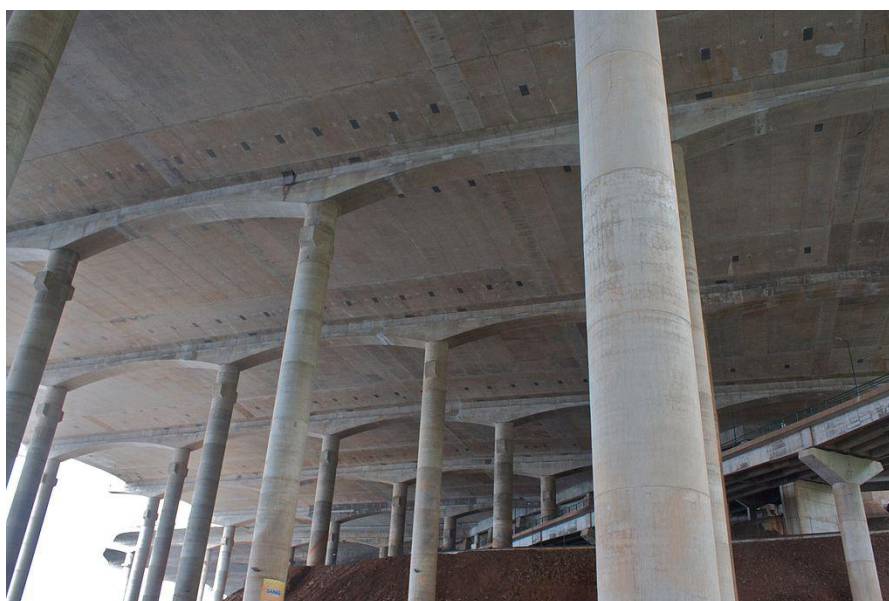
图 2- 11 建成后的门式刚架
