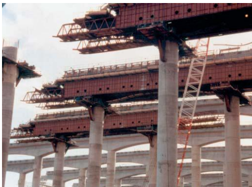
图 2- 14 门式梁施工
