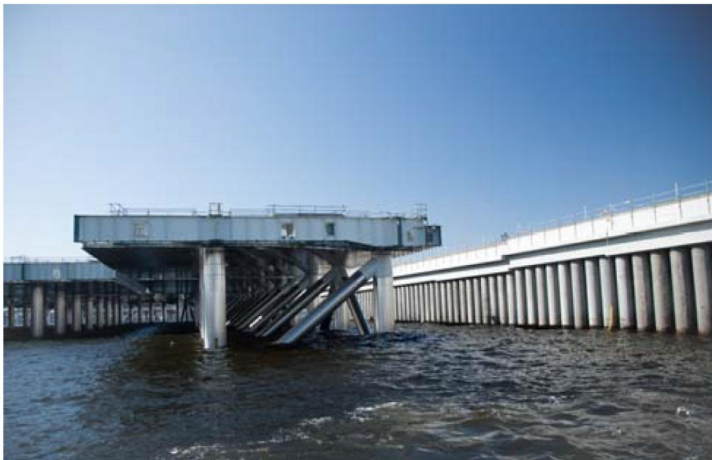
图 3- 17 消能排桩和钢套管上部结构（施工期间）
