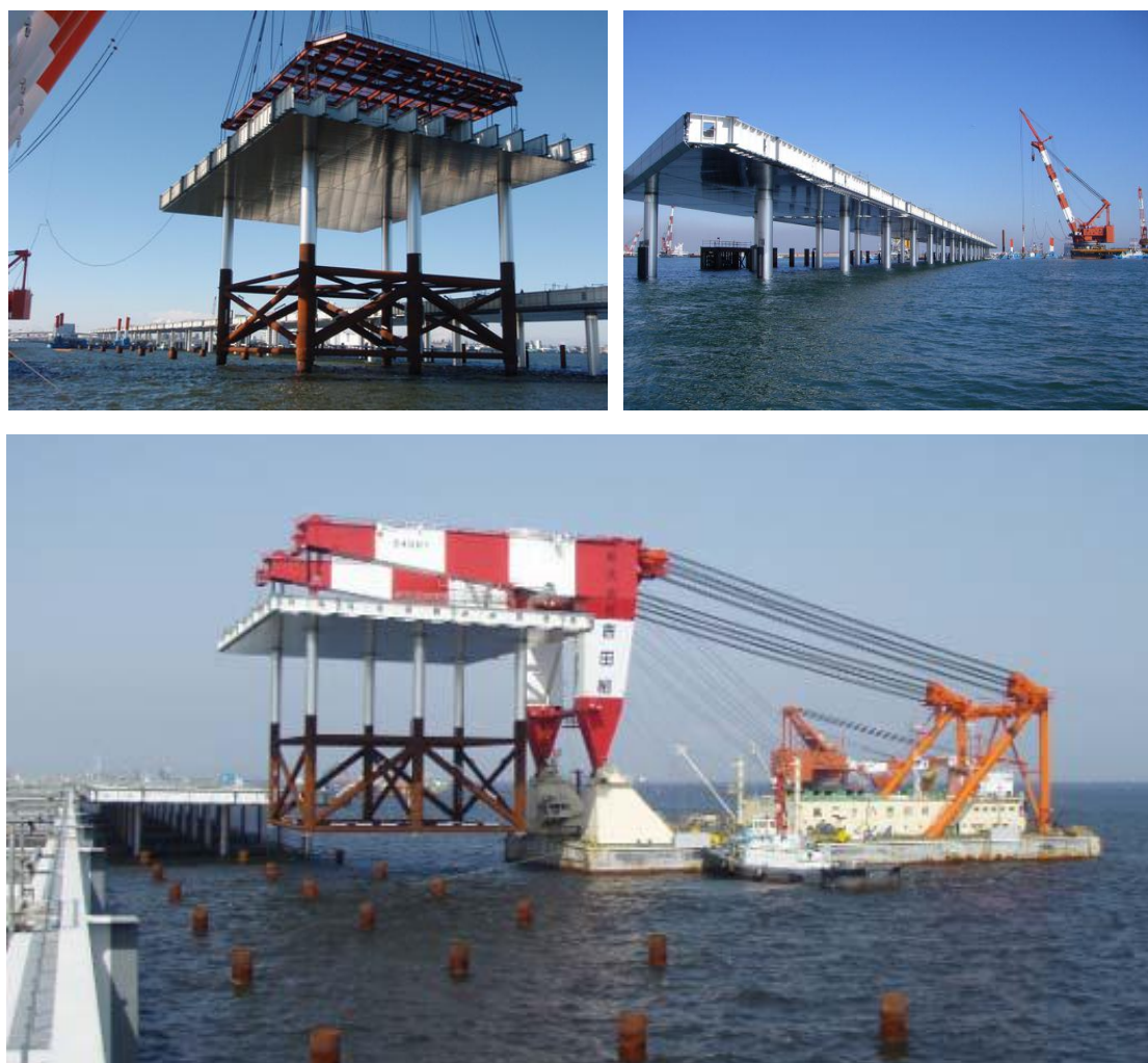
图 3-5 羽田机场 D 跑道桥梁施工现场
