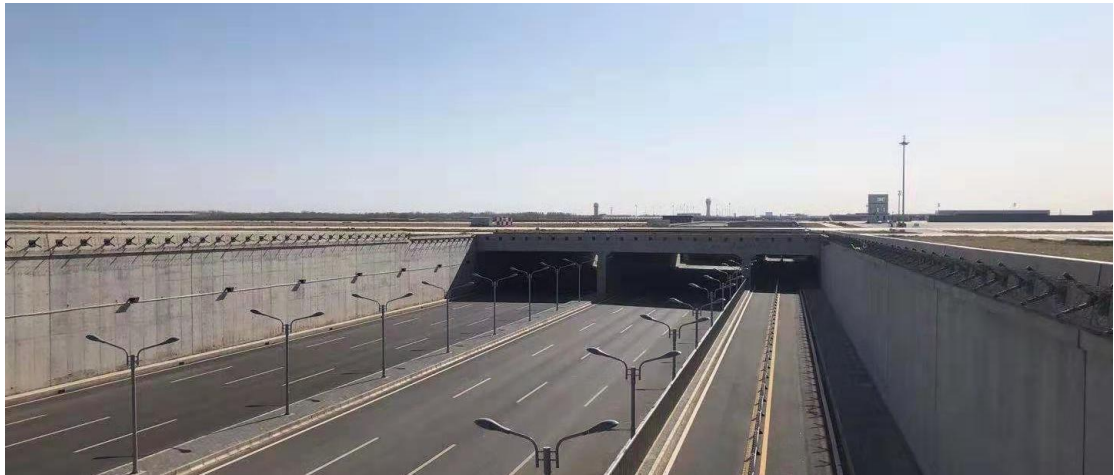
图 6- 6 北京大兴机场磁大路滑行道桥
