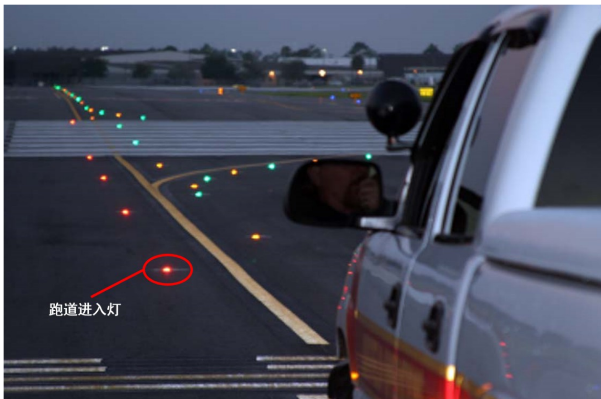
图 9—2—2 跑道进入灯基本构型（滑行道与跑道垂直）实拍图
