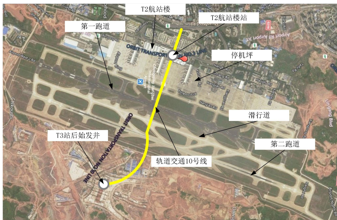
e) 重庆机场穿越工程
