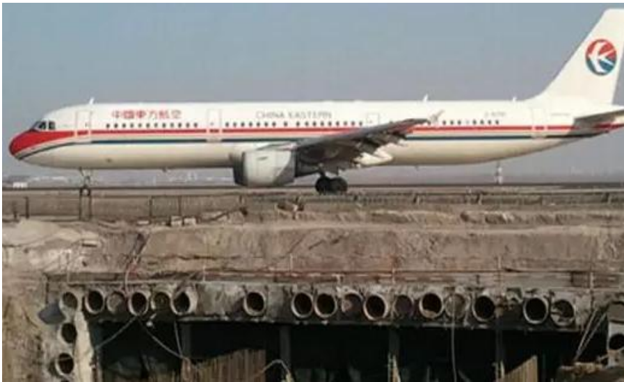
图 A-1-3 首都机场 T3E-T2 汽车（捷运）隧道下穿中跑道施工
