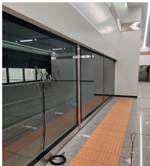
图 3.3-6 气压传感器安装
