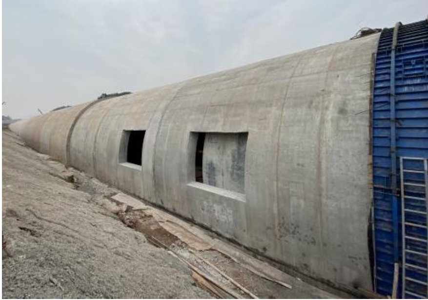
图 3.4-5 天府机场隧道洞口缓冲结构
