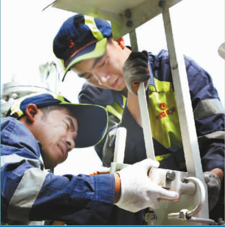
武汉航空加油站维修分队员工在维护保养设备。(危金林)
