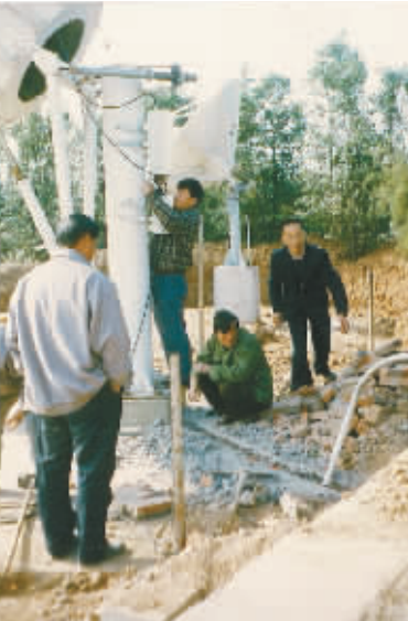
调试卫星设备现场
