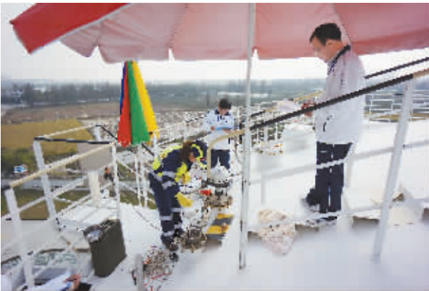
▶选手们在进行立式金属油罐内航空油品的高度测量。
