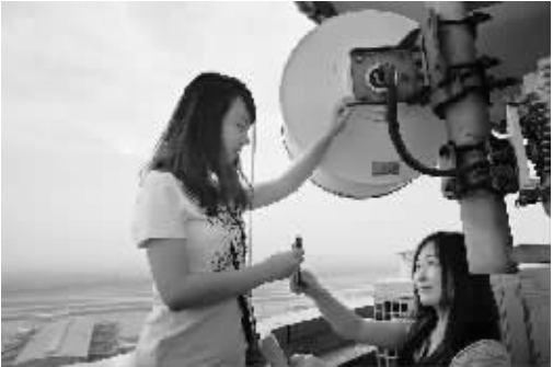
中南空管局女职工在现场维修设备。黄敏 摄
