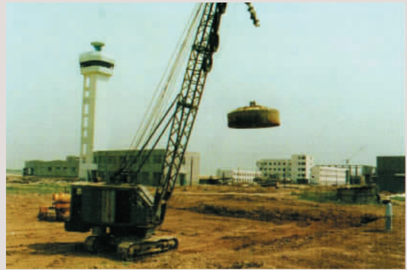
当西安咸阳机场一期工程修建跑道时,用强夯消除湿陷性大孔。
