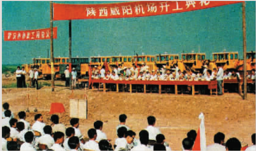
1987 年 8 月 20 日,西安咸阳机场一期扩建工程开工。
