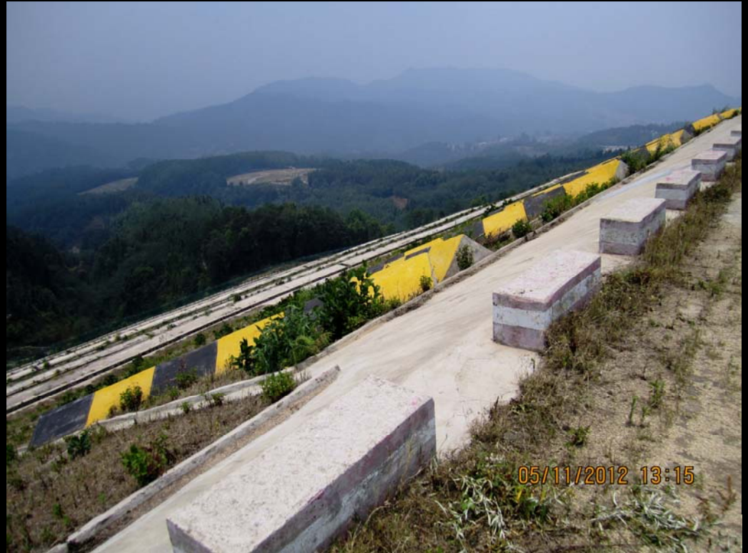
中国西部某机场跑道端外250米处
